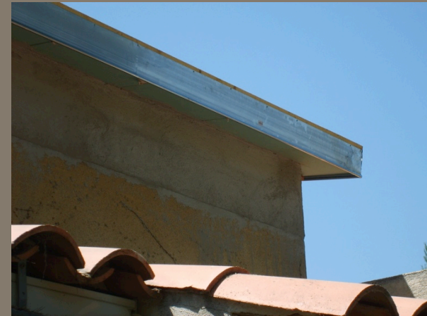
REPLACEMENT D'UNE TOITURE
